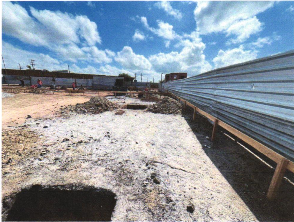
IMAGEM 07 LOCALIZAÇÃO CONVENCIONAL DE OBRA, ATRAVÉS DE GABARITO DE TABUAS CORRIDAS PONTALETADAS, SEM REAPROVEITAMENTO.
