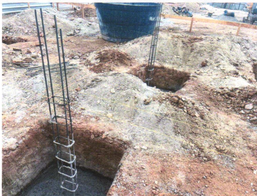
IMAGEM 18 - CONCRETAGEM DE PILARES, FCK = 25 MPA, COM USO DE BOMBA EM EDIFICAÇÃO COM SEÇÃO MÉDIA DE PILARES MENOR OU IGUAL A 0,25 M 2 - LANÇAMENTO, ADENSAMENTO E ACABAMENTO. AF_12/2015.
