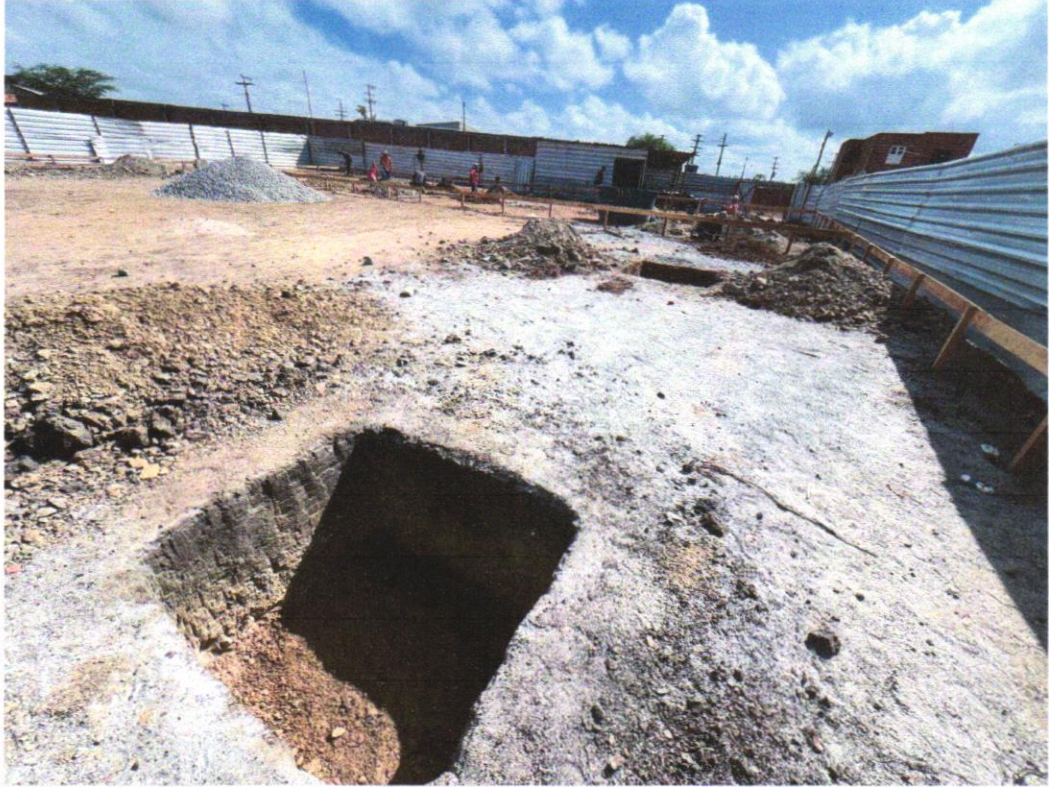
IMAGEM 11 – ESCAVAÇÃO MANUAL DE VALA COM PROFUNDIDADE MENOR OU IGUAL A 1,30 M. AF_02/2021.
