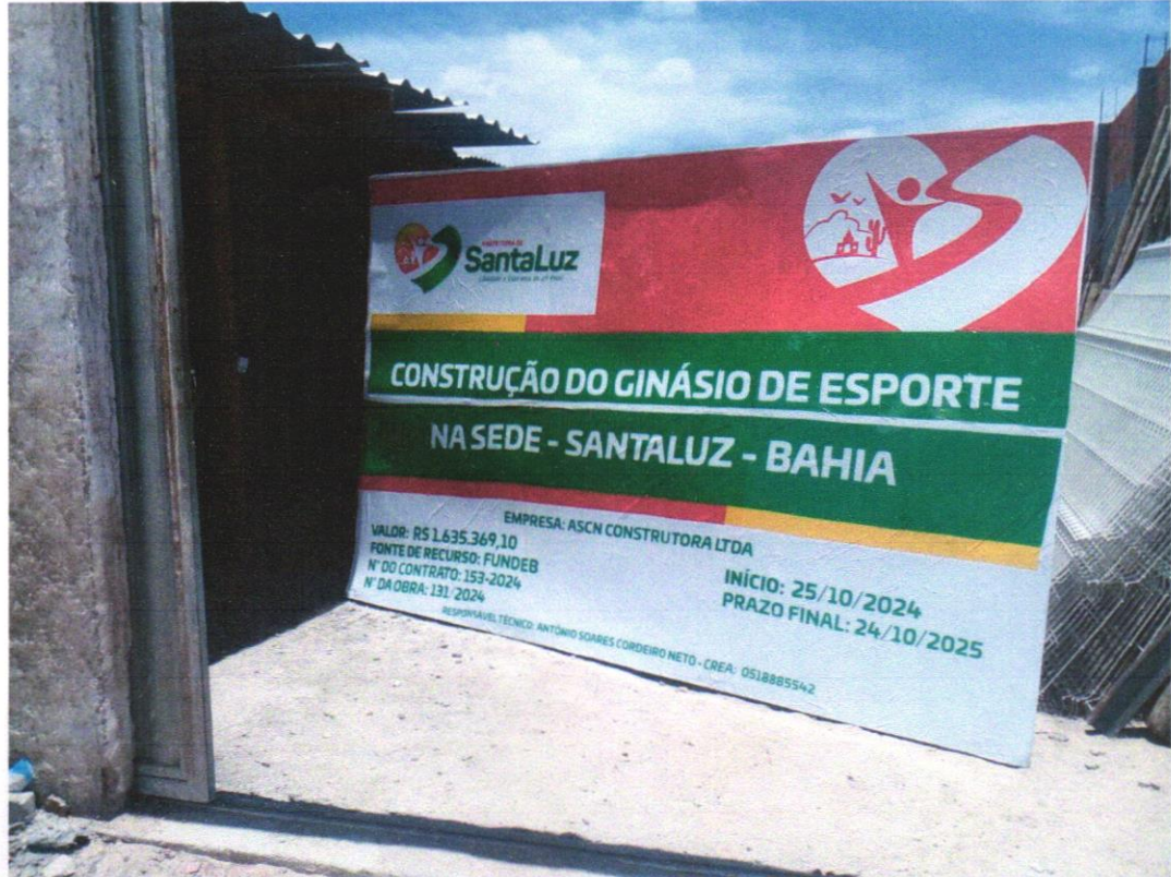
IMAGEM 01 - Placa de obra em chapa aço galvanizado, instalada - Rev 02_01/2022.
