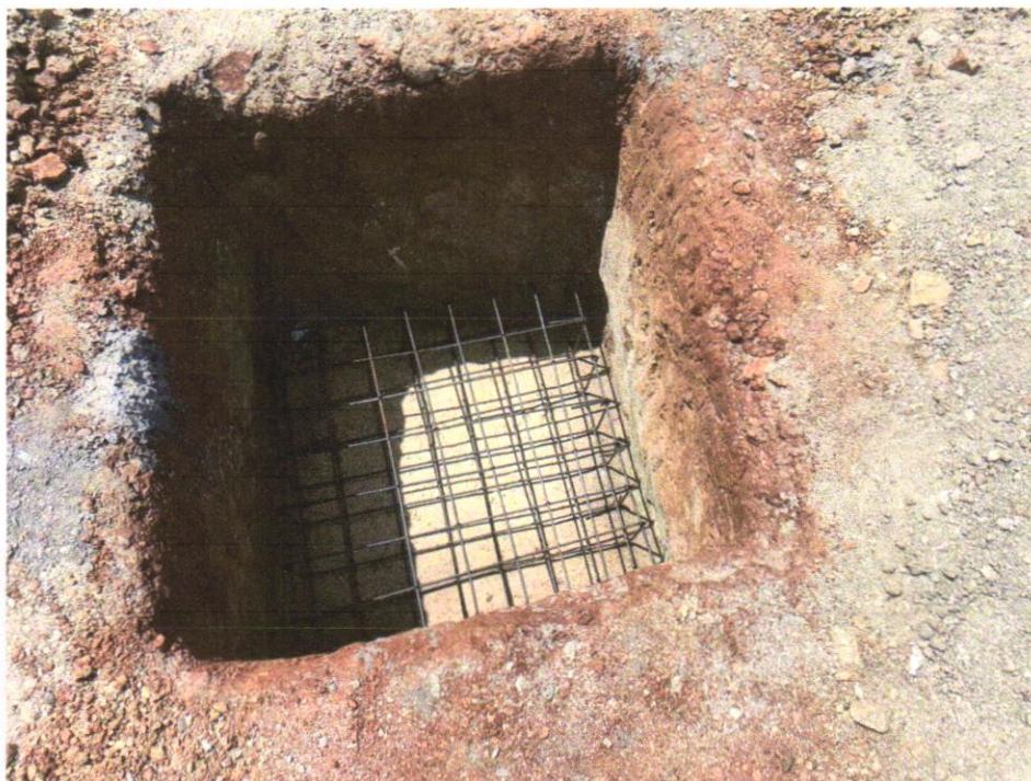
IMAGEM 15 - CORTE E DOBRA DE AÇO CA-60, DIÂMETRO DE 5,0 MM, UTILIZADO EM ESTRUTURAS DIVERSAS, EXCETO LAJES. AF_12/2015.
