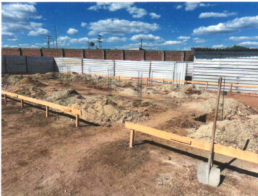
IMAGEM 09 - ATERRO MANUAL DE VALAS COM SOLO ARGILÓ-ARENOSO E COMPACTAÇÃO MECANIZADA. AF_05/2016.
