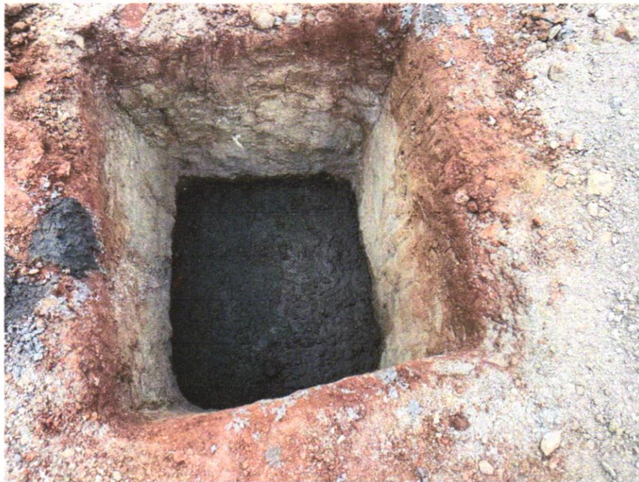
IMAGEM 12 – LASTRO DE CONCRETO MAGRO, APLICADO EM PISOS, LAJES SOBRE SOLO OU RIACHÃO DO JACUIPE-BAHIA, 30 DE OUTUBRO DE 2024
