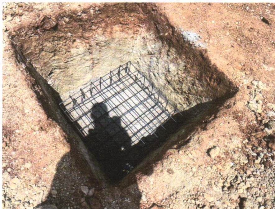
IMAGEM 14 – CORTE E DOBRA DE AÇO CA-50, DIÂMETRO DE 8,0 MM, UTILIZADO EM ESTRUTURAS DIVERSAS, EXCETO LAJES. AF_12/2015
