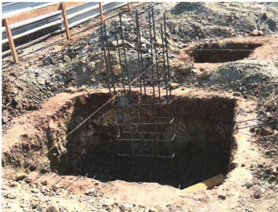
IMAGEM 13 – CORTE E DOBRA DE AÇO CA-50, DIÂMETRO DE 8,0 MM, UTILIZADO EM ESTRUTURAS DIVERSAS, EXCETO LAJES. AF_12/2015.
