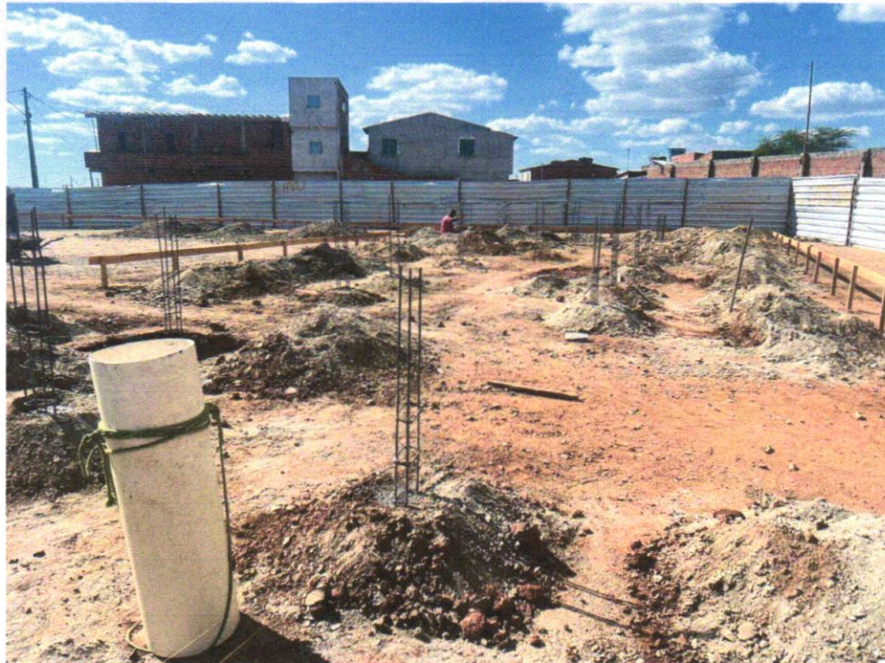
IMAGEM 08 - ATERRO MANUAL DE VALAS COM SOLO ARGILÓ-ARENOSO E COMPACTAÇÃO RIACHÃO DO JACUIPE-BAHIA, 30 DE OUTUBRO DE 2024
