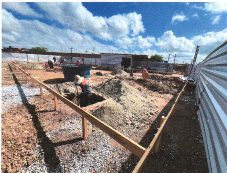
IMAGEM 10 ESCAVAÇÃO MANUAL DE VALA COM PROFUNDIDADE MENOR OU IGUAL A 1,30 M. AF_02/2021.
