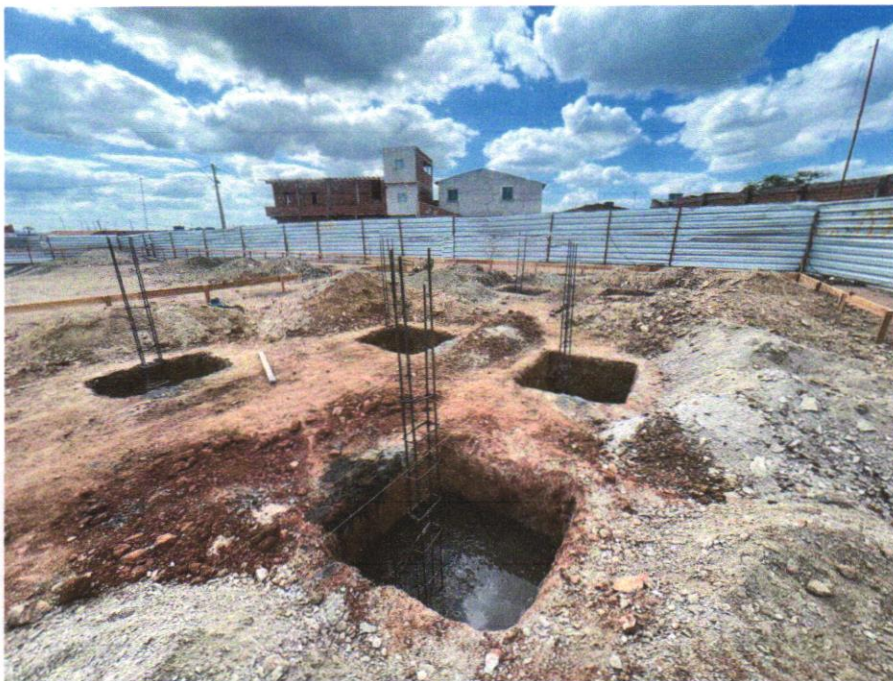
IMAGEM 17 - CONCRETAGEM DE PILARES, FCK = 25 MPA, COM USO DE BOMBA EM EDIFICAÇÃO COM SEÇÃO MÉDIA DE PILARES MENOR OU IGUAL A 0,25 M 2 - LANÇAMENTO, ADENSAMENTO E ACABAMENTO. AF_12/2015.
