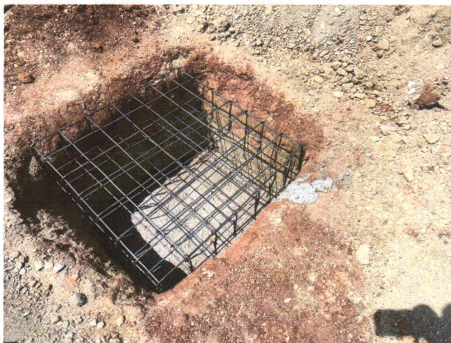
IMAGEM 16 - CORTE E DOBRA DE AÇO CA-60, DIÂMETRO DE 5,0 MM, UTILIZADO EM RIACHÃO DO JACUIPE-BAHIA, 30 DE OUTUBRO DE 2024
